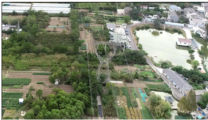
图 3-56 待拆迁 500kV 高压塔
