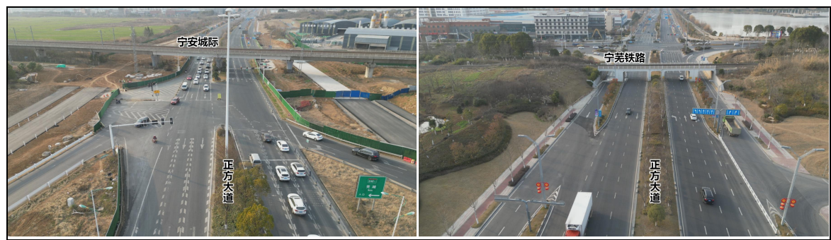
图 4-13 宁安城际与宁芜铁路
