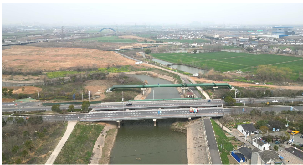
图 4- 69 正方大道跨江宁河桥
