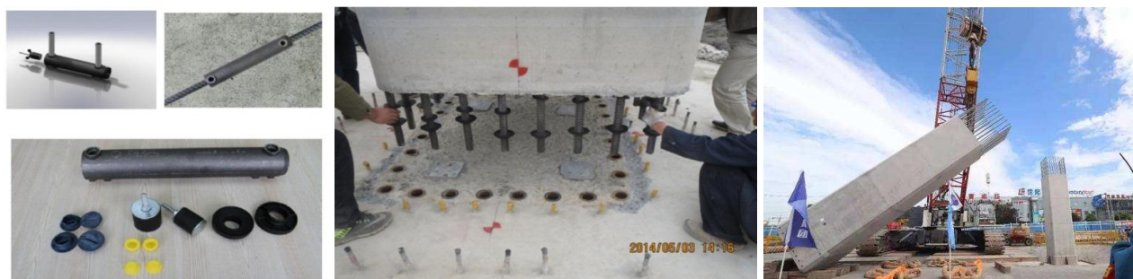
墩柱预制拼装施工照片（墩柱吊装、套筒、套筒对接）
