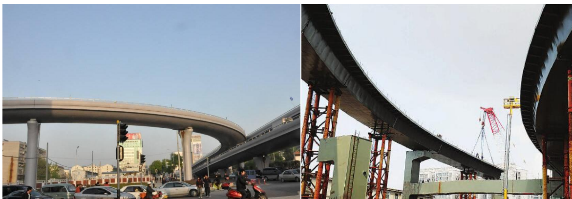
钢箱梁辅道（匝道）桥
