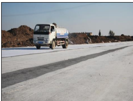
路基顶部铺布养护
