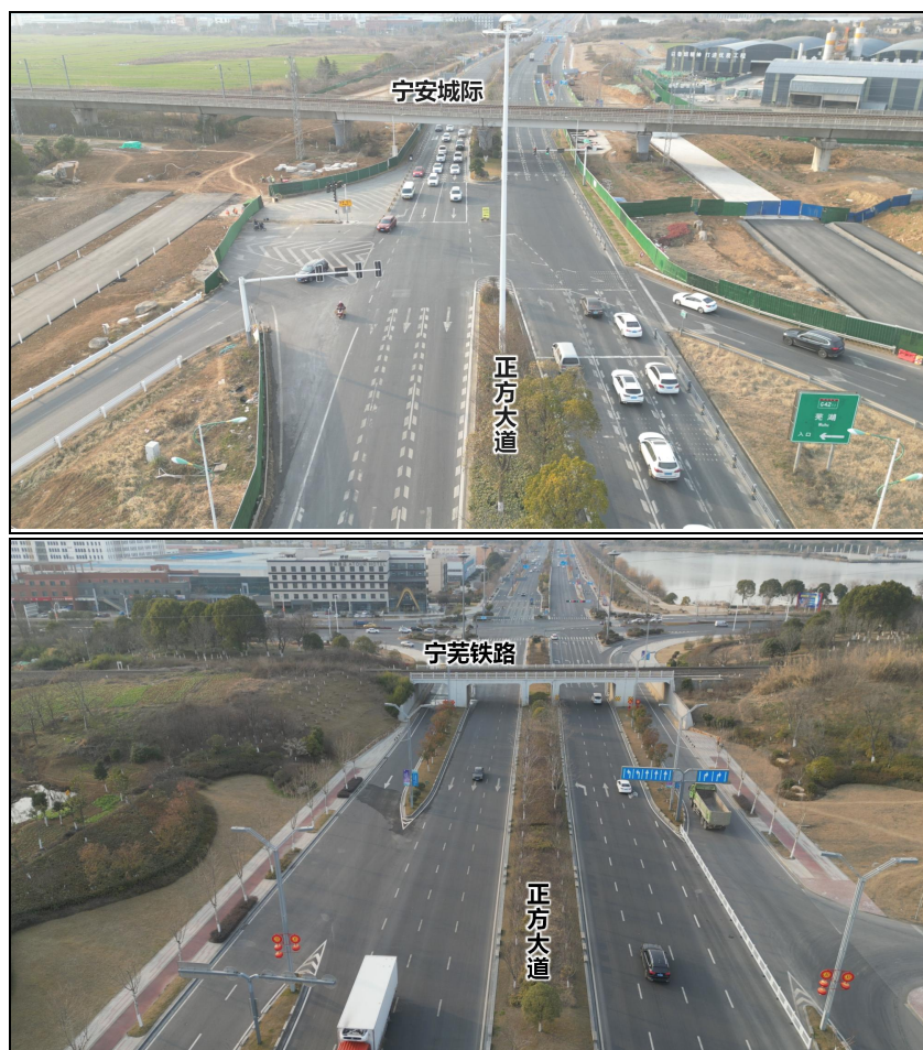
图 3-100 宁安城际与宁芜铁路
