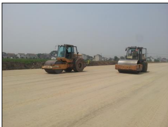
现场碾压成品灰土
