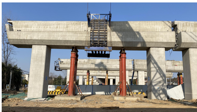
图 4-16 盖梁支架现浇施工工艺
