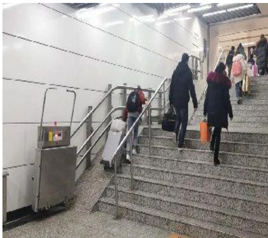
坡道改造前乘客艰难换乘
