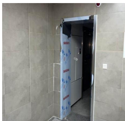
更换残卫门体
